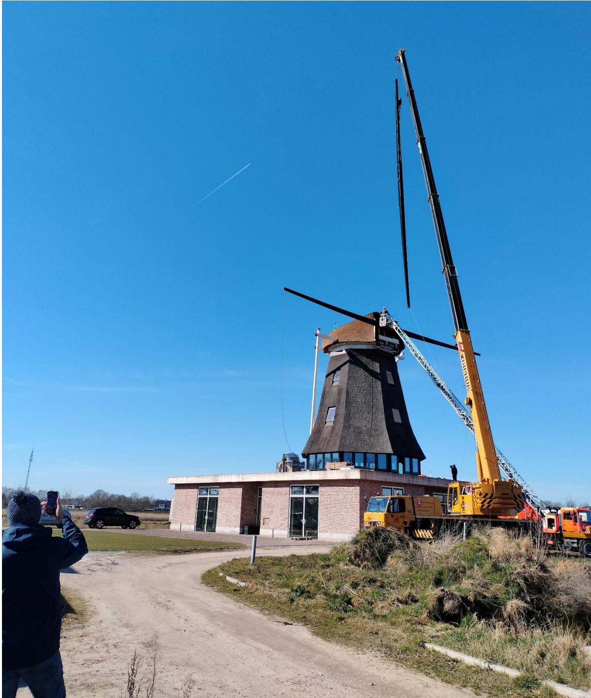
Henry Franken filmt het plaatsen van de roeden op de Weseper energiemolen.
